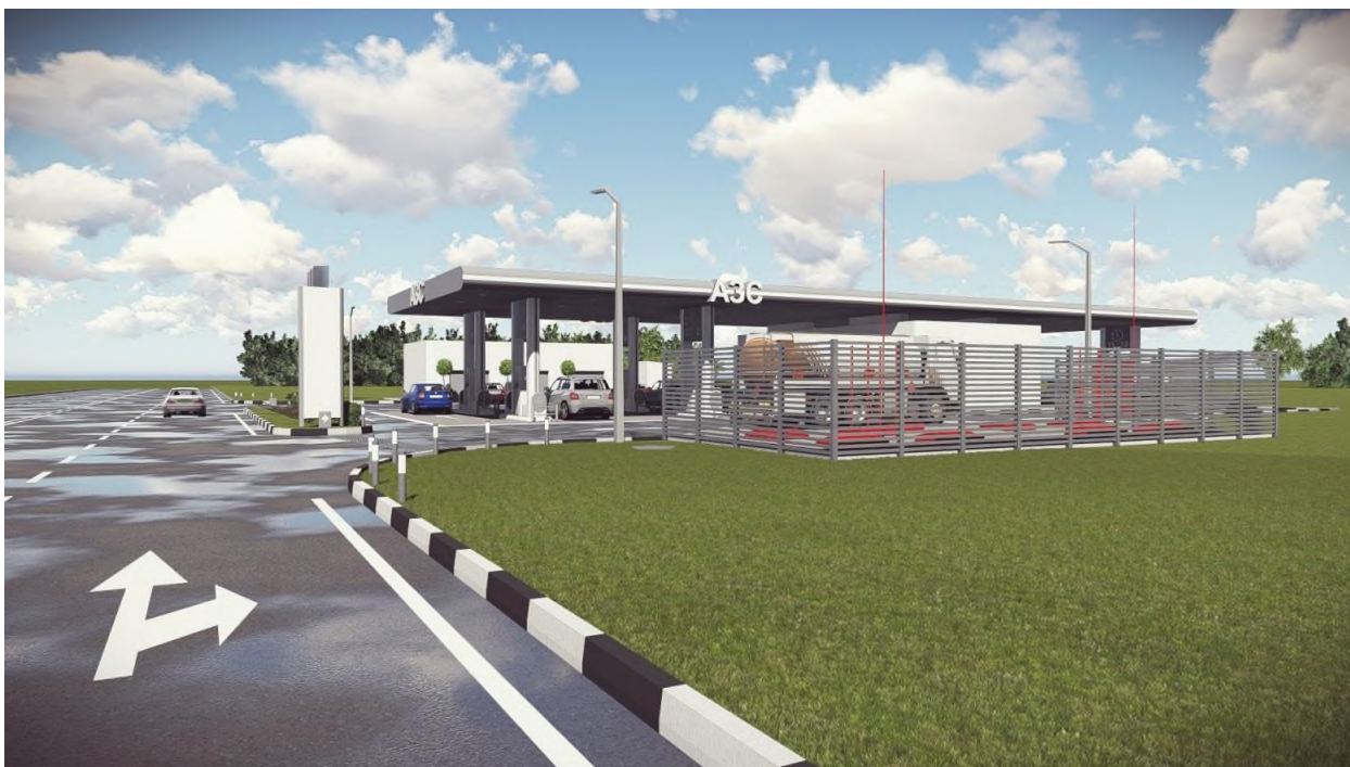
Ограждение мусорных контейнеров и контейнеров хранения топлива
